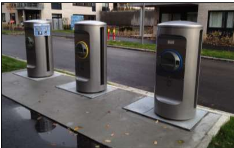
Figur 3-5: Nedkast til stasjonært avfallssug – 3 avfallstyper
