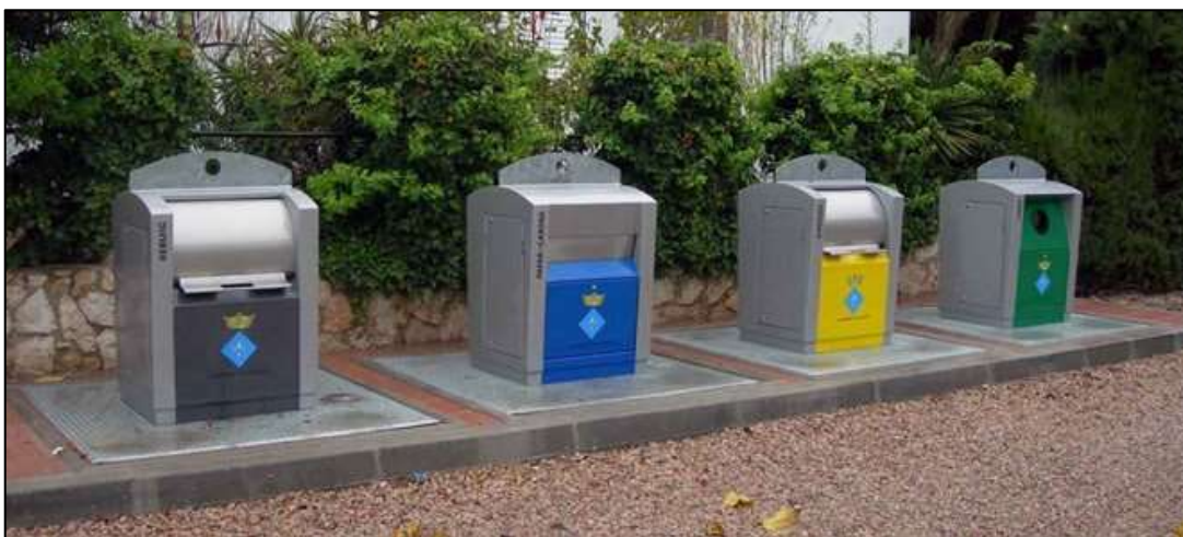
Figur 3-4: Helt nedgravd containerløsning for 4 avfallstyper
